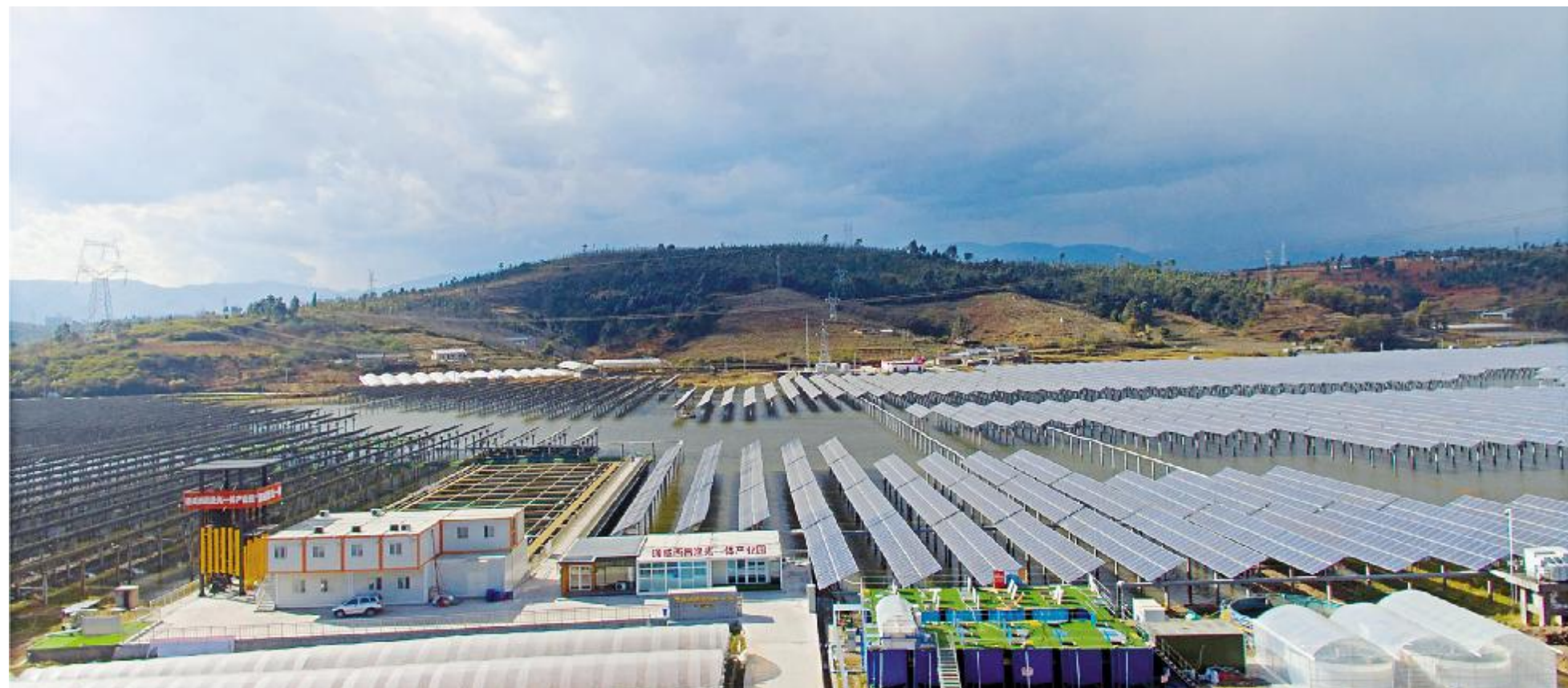
通威西昌“渔光一体”基地
